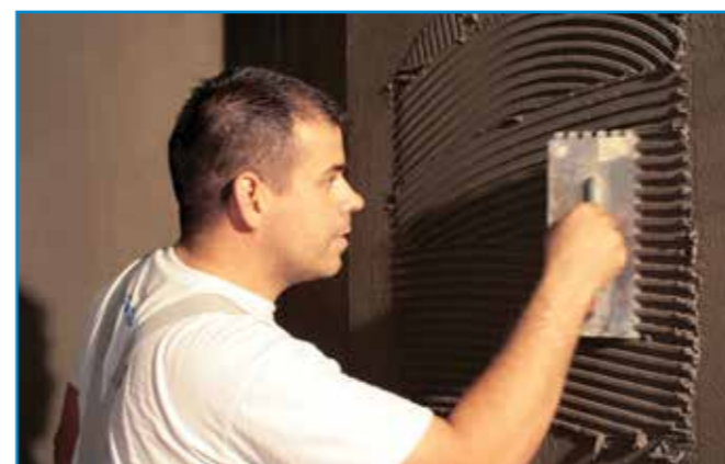
A szükséges ragasztómennyiség felhordását a glettvass fogmelységével és döntésével szabályozhatjuk.
